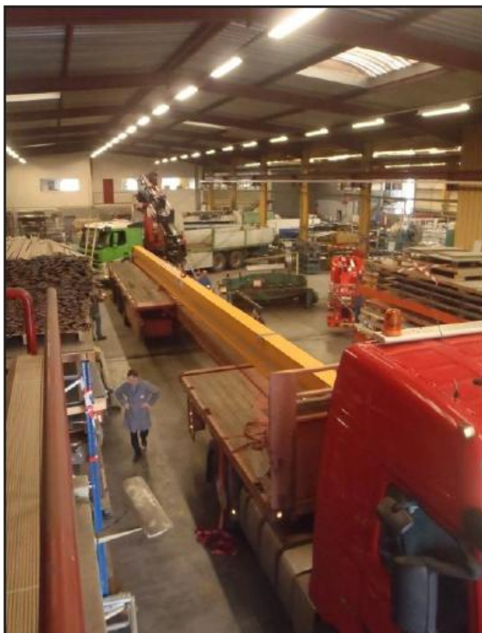
■ L'installation d'un pont roulant chez Balin, un investissement qui permettra de ménager les personnels. Photo DR
